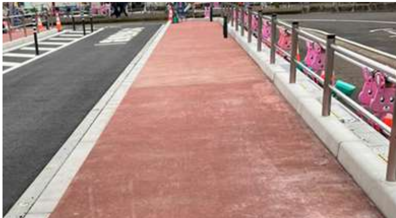
写真-7 一般部施工状況
