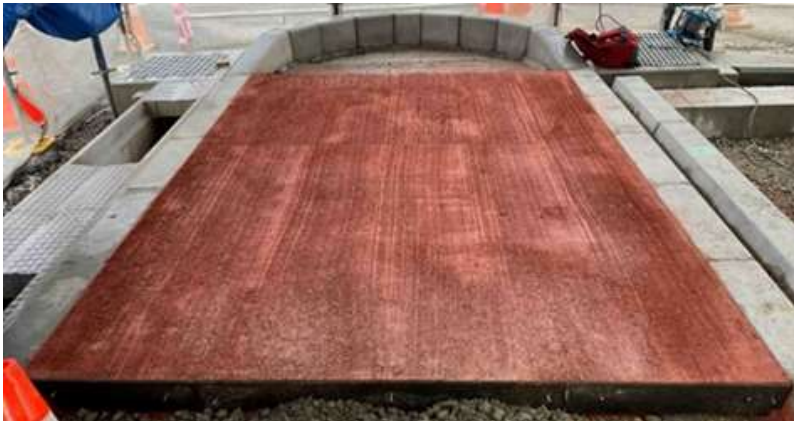
写真-5 実験部施工状況
