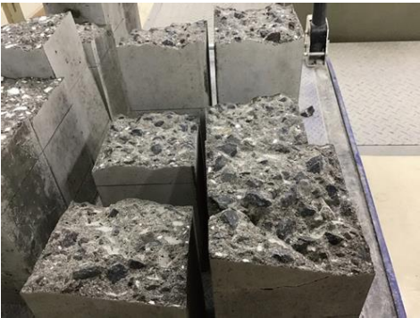
写真－4 No3:砕石粗骨材が割れているものもある
